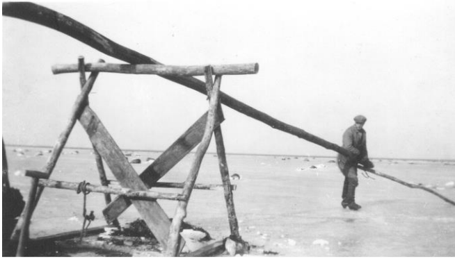
Også om vinteren blev der fisket sten på Odense Fjord. Ved hjælp af vægtstangsprincippet blev stenene løftet fri af bunden. Transporten til land foregik på slæde
