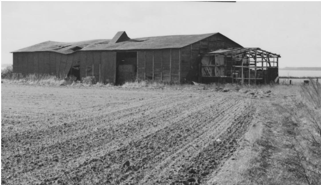
Den store hal på Tornø, hvor skallerne blev pakket og opbevaret, inden de blev sendt ud til hønserier og til den keramiske industri.
