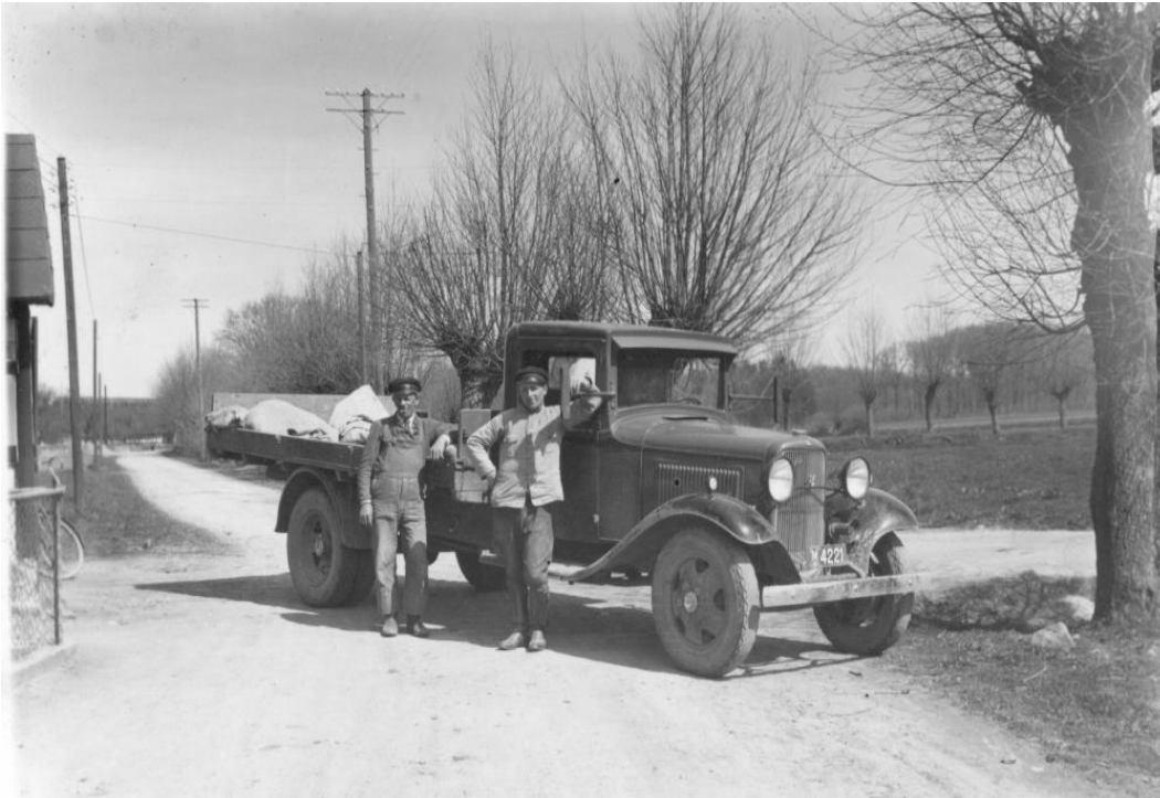
Morten Jørgensens lastbil, der blev brugt til transport af de rengjorte skaller. Transporten gik via den nyetablerede dæmning til Tornø.
