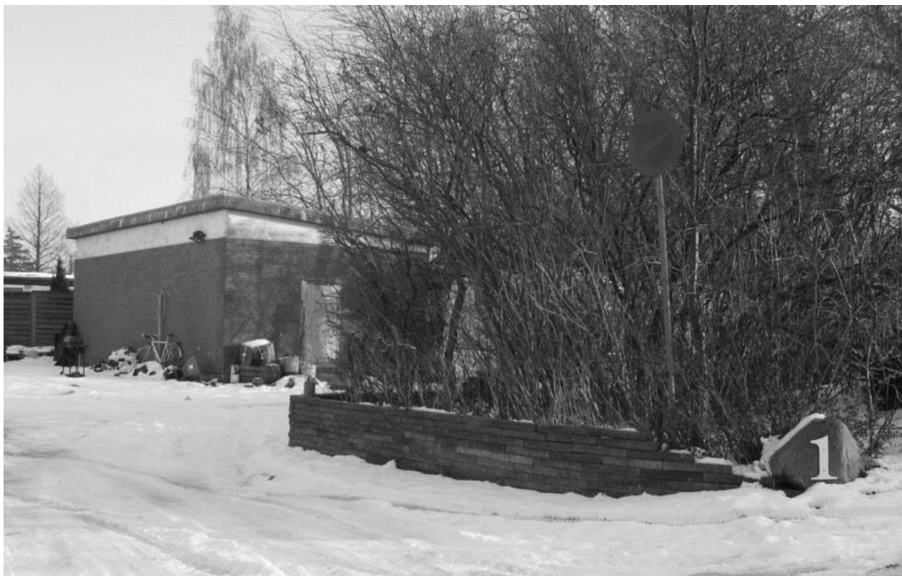
Bygningen på Dybendalen 1, der husede Munkebo central i perioden 1966-1978, foto 2006
