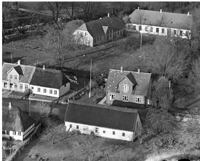
Det oprindelige hus på 19a i forgrunden.
